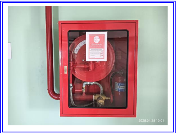
รูปที่ 2.9-4 ตู้เก็บสายฉีดน้ำดับเพลิง
