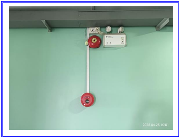
รูปที่ 3.1-34 อุปกรณ์แจ้งเหตุเพลิงไหม้แบบใช้มือ
